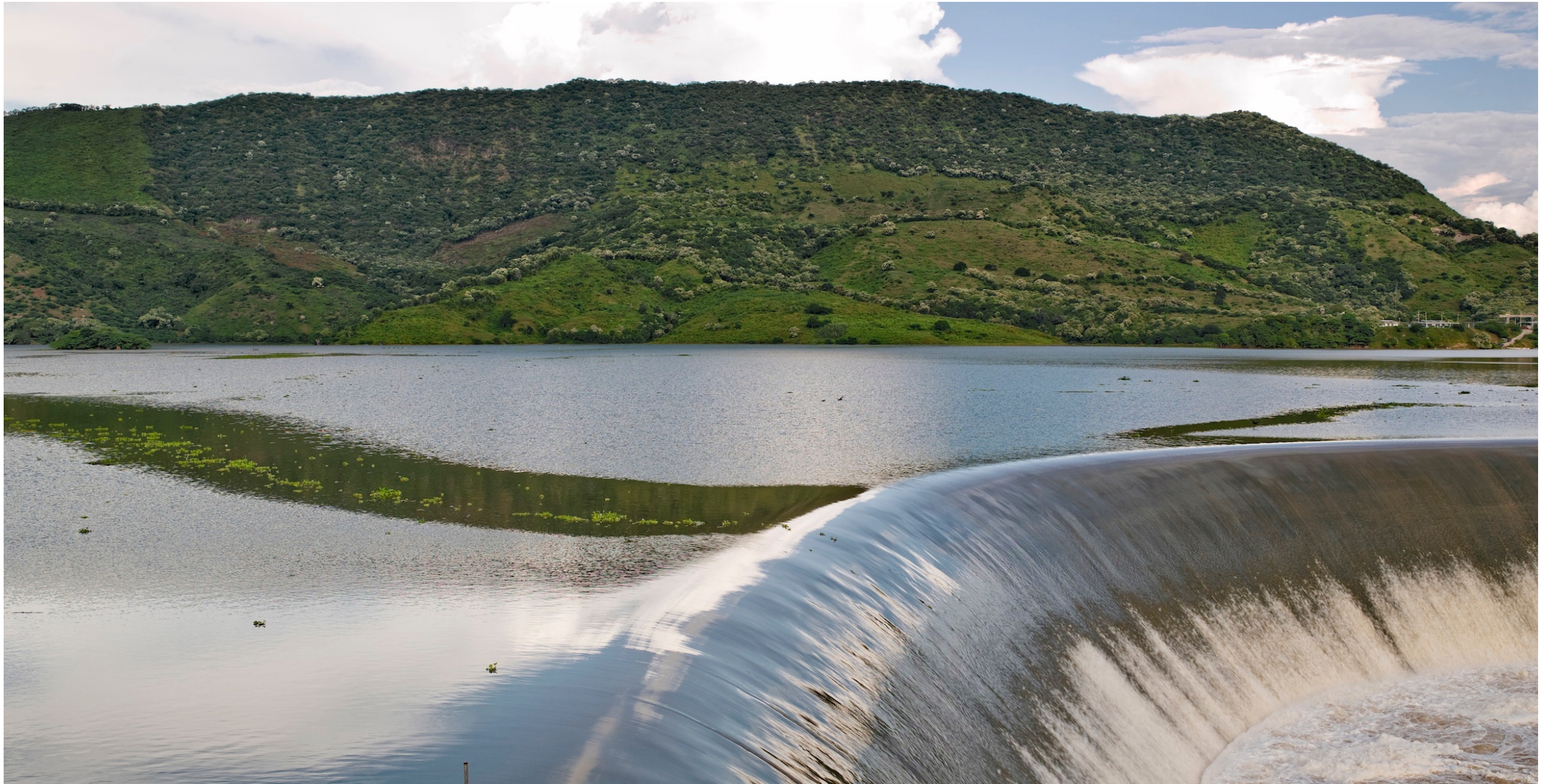
Impianto Enel Green Power El Gallo, Guerrero, Messico - 30 MW
