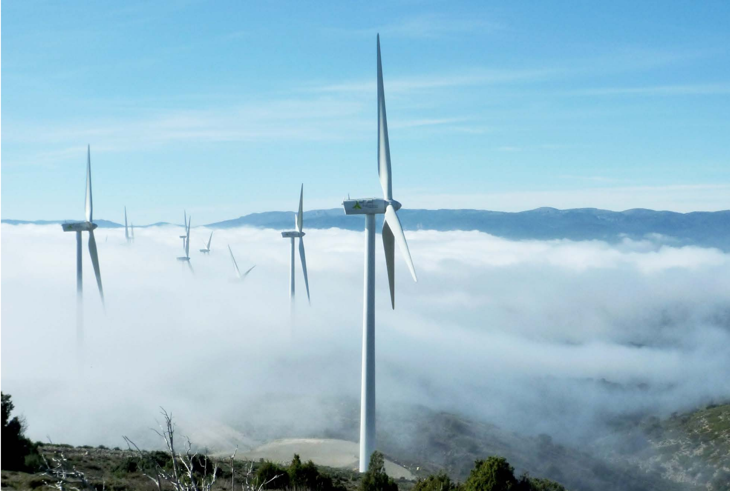
Impianto Enel Green Power Alto Casillias, Barracas, Spagna - 30 MW
