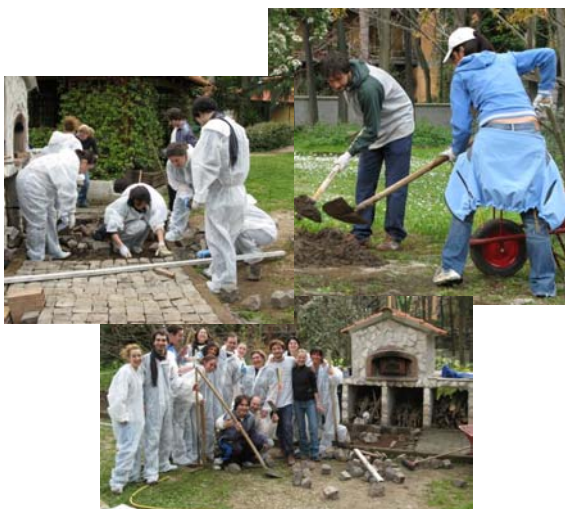
La realizzazione della pavimentazione
